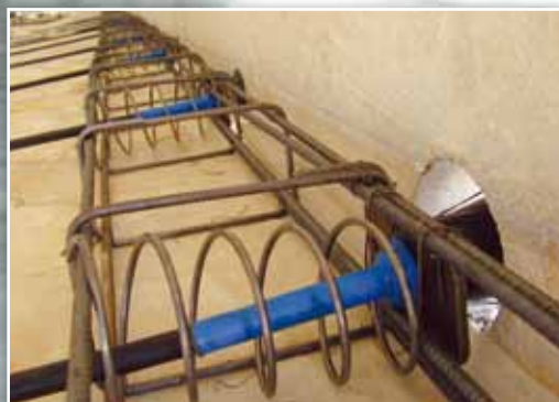
Testata attiva disposta per tesature esterne-perimetrali
